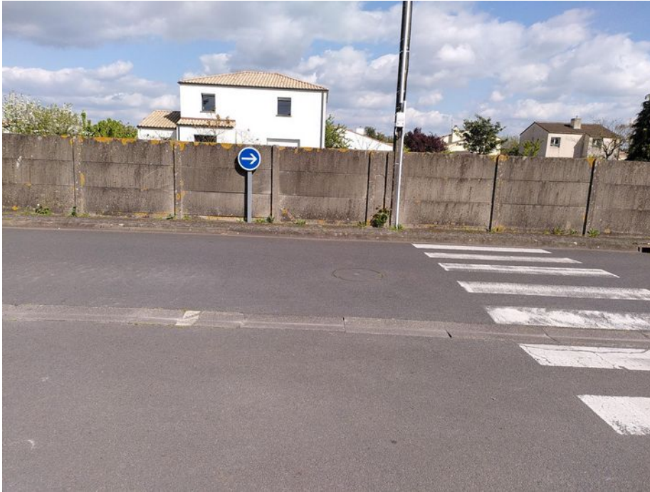
Sens de circulation, à l'entrée du parking, faisant face aux voitures sortantes.
